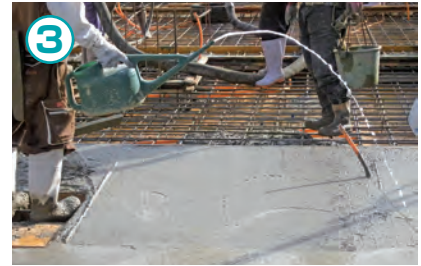
③ コンキョートをジョウロまたは噴霧器で散布 使用量5倍希釈液で0.1kg/m 2
