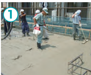
① 生コン打設 → トンボ均し → コンキョートの散布(1回目) 使用量5倍希釈液で0.1kg/m 2
