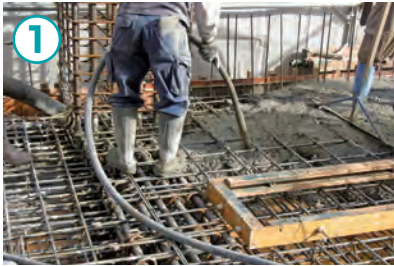
① 生コン打設
