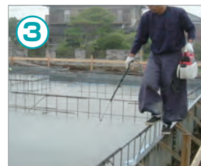
③ 仕上げ押さえ後、直ちに → コンキョートの散布(2回目) 使用量5倍希釈液で0.1kg/m 2
