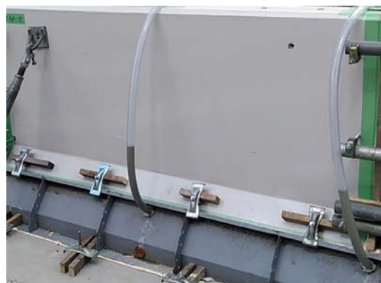
プレキャスト部材の接合部への充填 (充填完了後ハイパフォーマンスモルタルがオーバーフローした状態)
